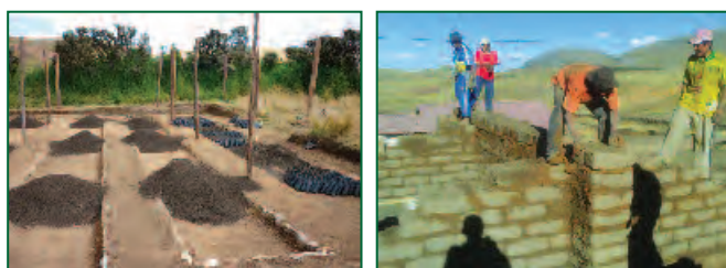
Fotos 3 y 4. Construcción de biohuertos y del muro Trombe a cargo de la población de San Francisco de Raymina.
