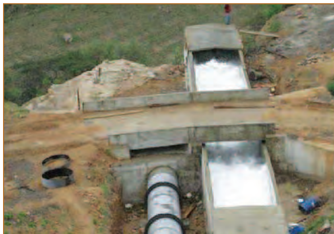
Foto 3. Fotografía vertedero de excedencias/canal de evacuación de excedencias de PCH en Perú (Fuente: GCZ Ingenieros SAC).
