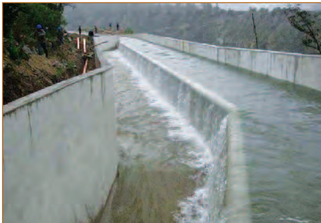
Foto 1. Vertedero de excedencias de PCH en Perú (Fuente: GCZ Ingenieros SAC).
