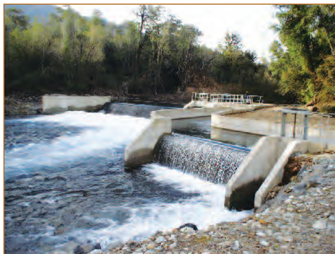
Foto 6. Obra de Toma en Rio Cuchildeo, Hornopirén, Chile.
