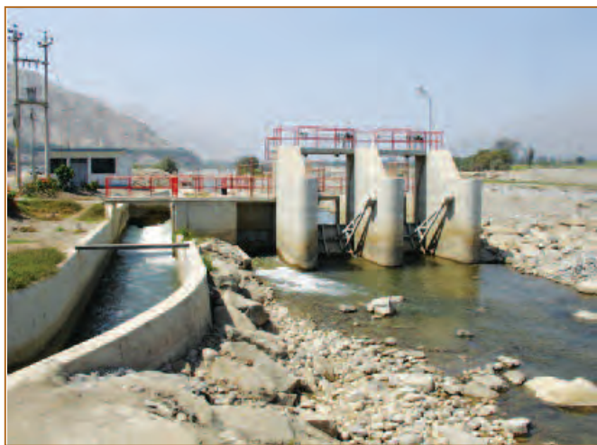
Foto 5. Obra de Toma MCH Santa Rosa, Perú.
